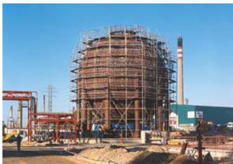
▲ Andamio BRIO en trabajos de mantenimiento industrial
