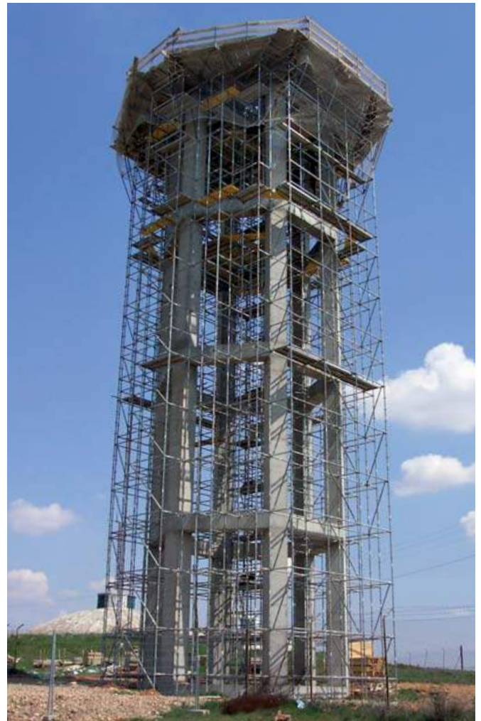
▲ Apeo de depósito a 24 m de altura
