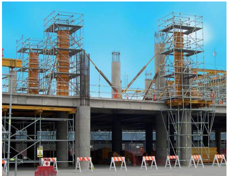
▲ Torres de hormigonado de pilares en ampliación del Aeropuerto Jorge Chávez, Lima, Perú
