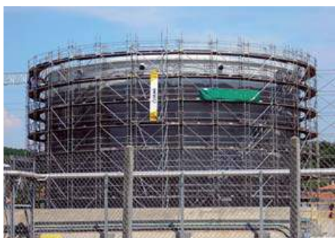
▲ Mantenimiento en depósito circular
