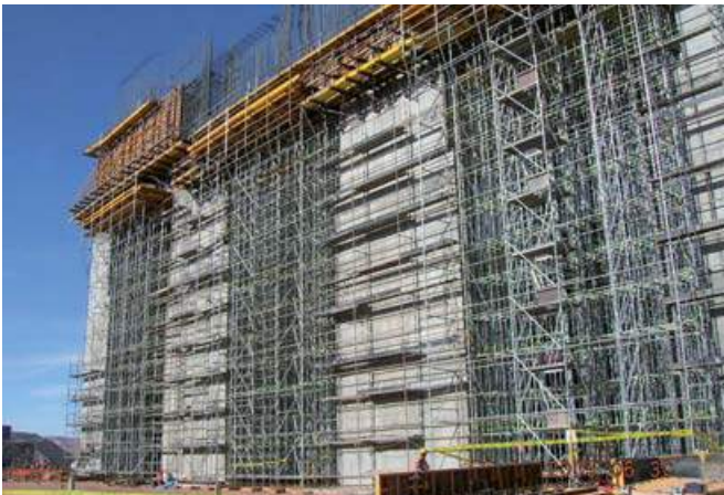
▲ Ejecución de losas a gran altura
