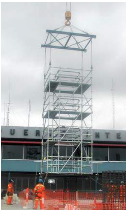
▲ Izado y traslado de torres
