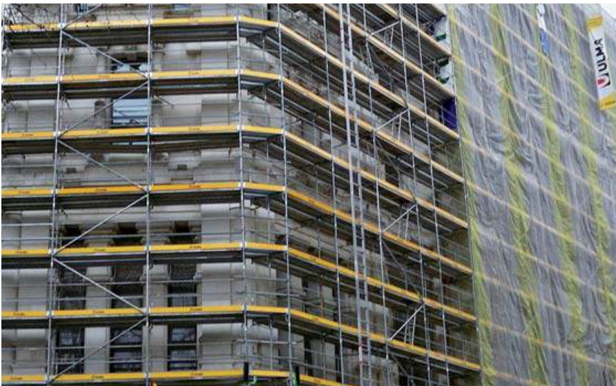
▲ Niveles de trabajo protegidos mediante barandillas y rodapiés
