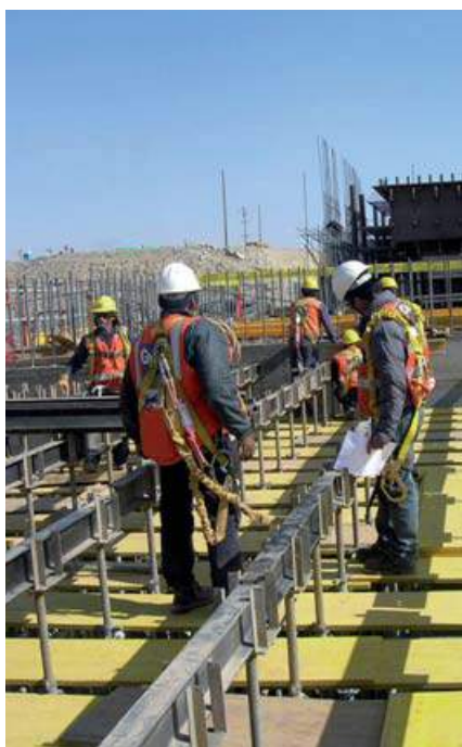
▲ Generación de espacios de trabajo seguros en la zona de montaje del encofrado y en las zonas perimetrales ▲
