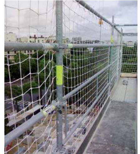
▲ Red de protección reforzada perimetralmente
