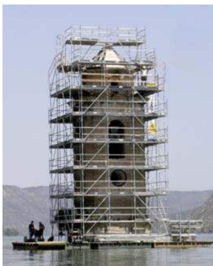
▲ Montaje de andamio en torre
