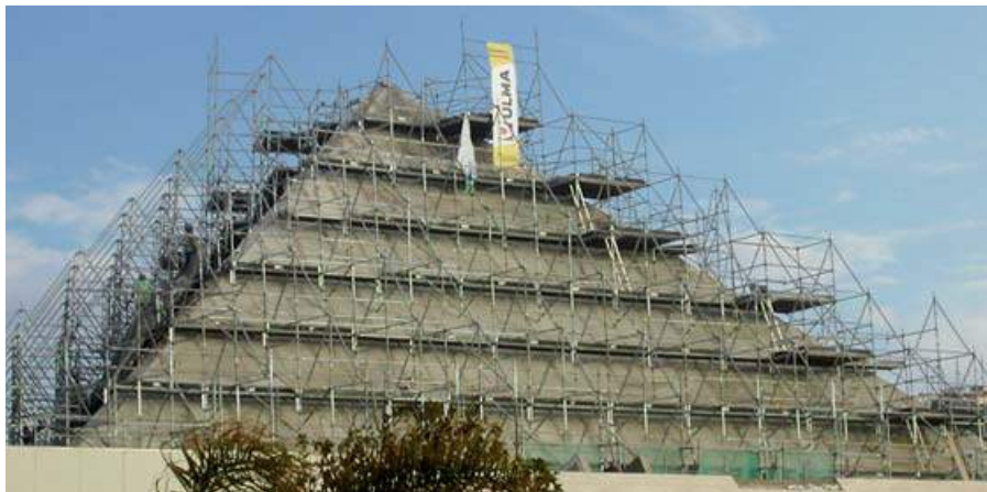
▲ Andamio Multidireccional BRIO en fachada inclinada
