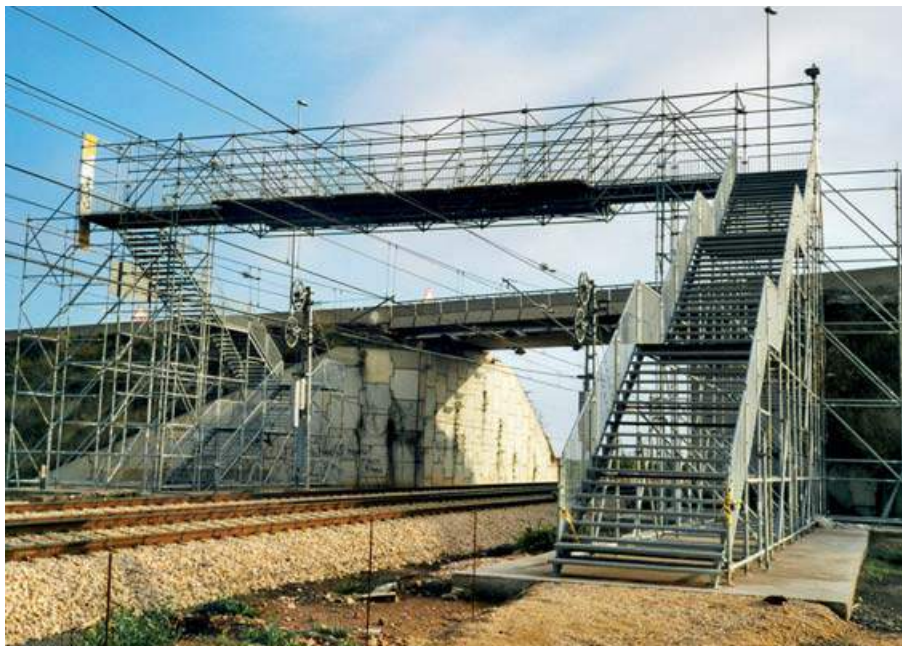
▲ Pasarela peatonal para salvar vías del tren
