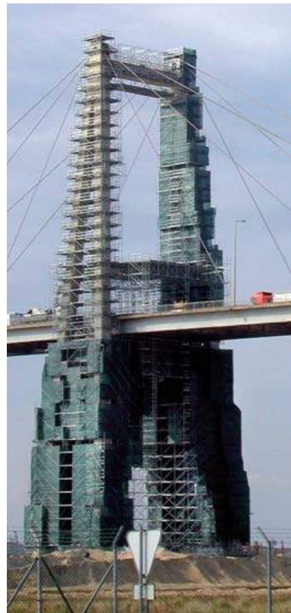
▲ Restauración del Ponte Figueira Da Foz, Portugal
